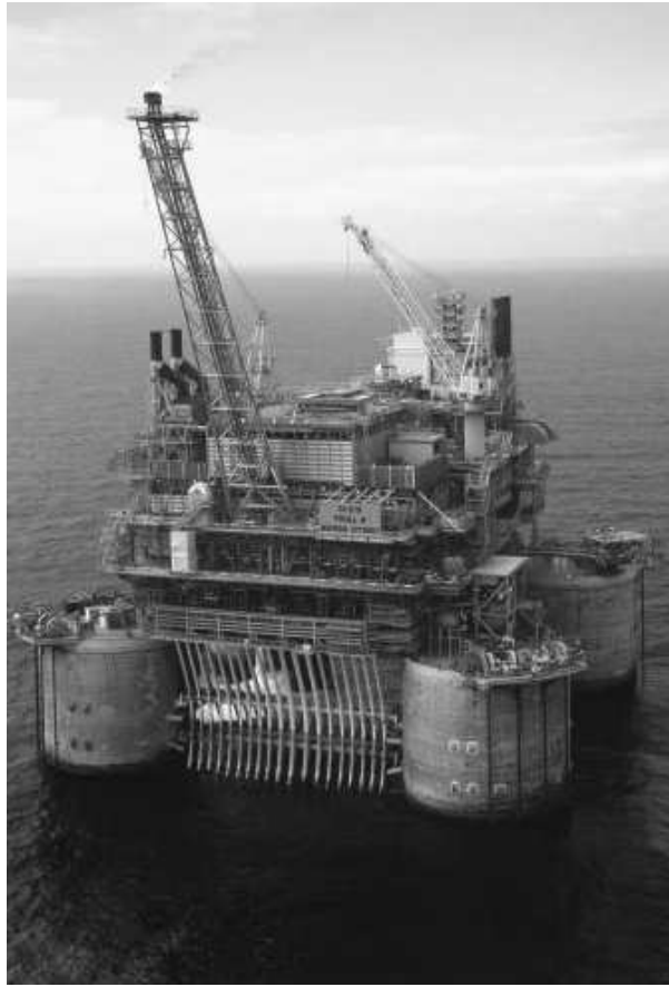
FIG. 1.7 – La plate-forme semi-submersible de production de Troll Olje.
