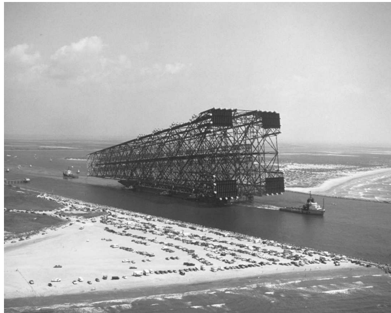
FIG. 1.2 – Le jacket de Bullwinkle en cours de remorquage.
