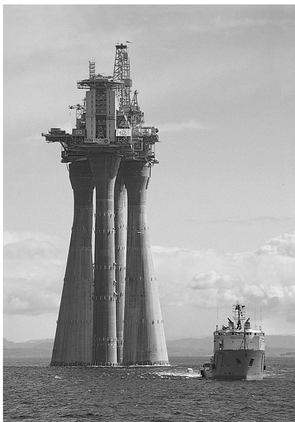
FIG. 1.4 – La plate-forme gravitaire de Troll en cours de remorquage.
